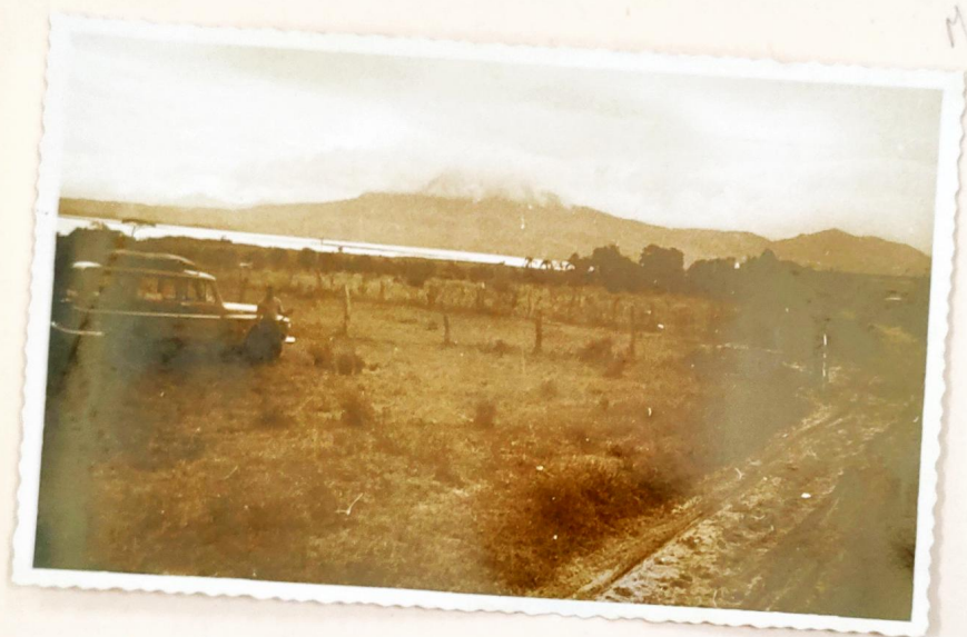
VISTA GERAL DE M-36: RAMALHETE-2, PELO NORDESTE AO FUNDO A LAGOA DO RAMALHETE E MORRO ALTO
